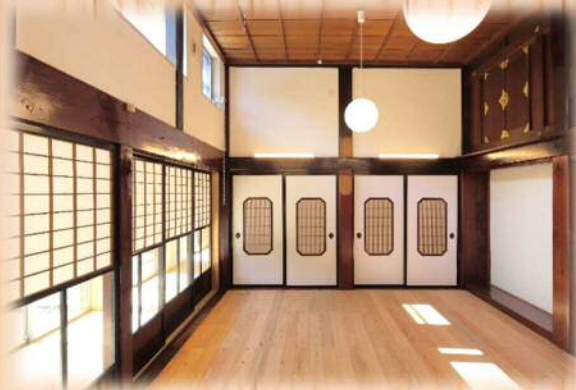
施工例：畳敷きだった和室を杉の無垢材に。 歴史と調和し快適な空間を実現しました。
